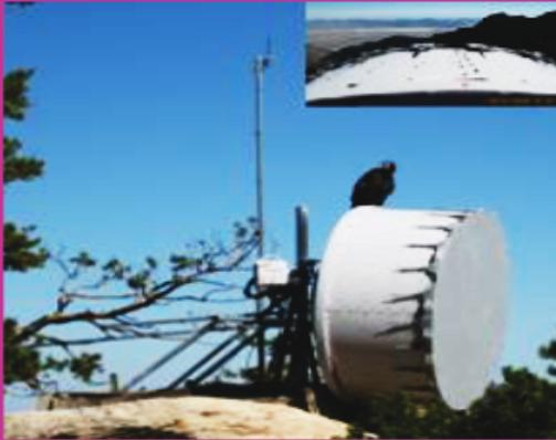
Figura 1. Antena de Radio del E1 en el OAN dirigida a su contraparte en la subestación de TELNOR "Dorado Ranch".
